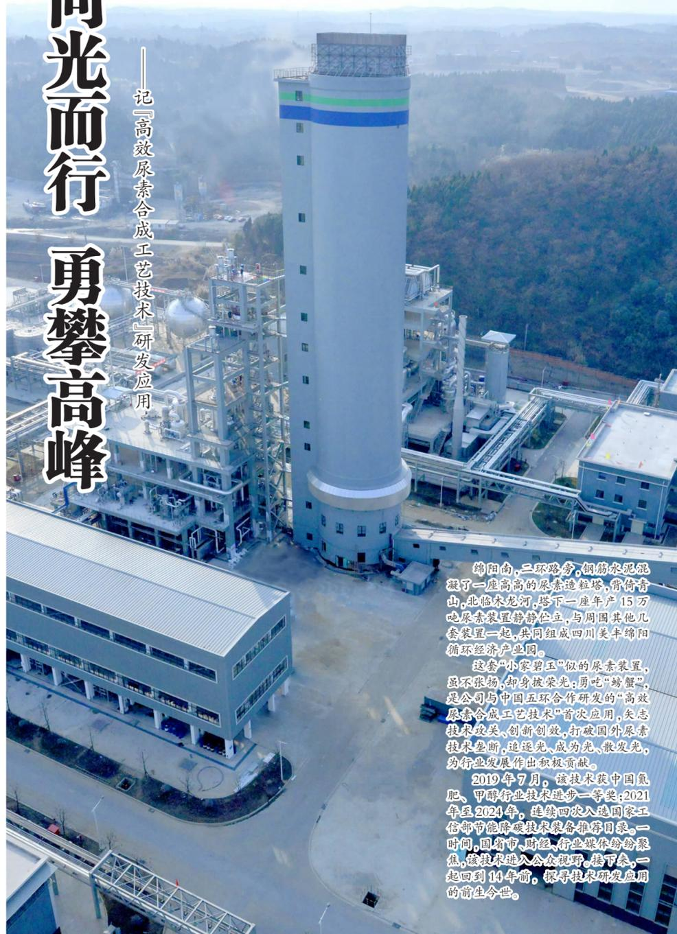
绵阳南,二环路旁,钢筋水泥浇筑了一座高高的尿素造粒塔,背倚青山,北临涪江河,塔下一座年产 15 万吨尿素装置静静伫立,与周围其他几套装置一起,共同组成四川美丰绵阳循环经济产业园。
