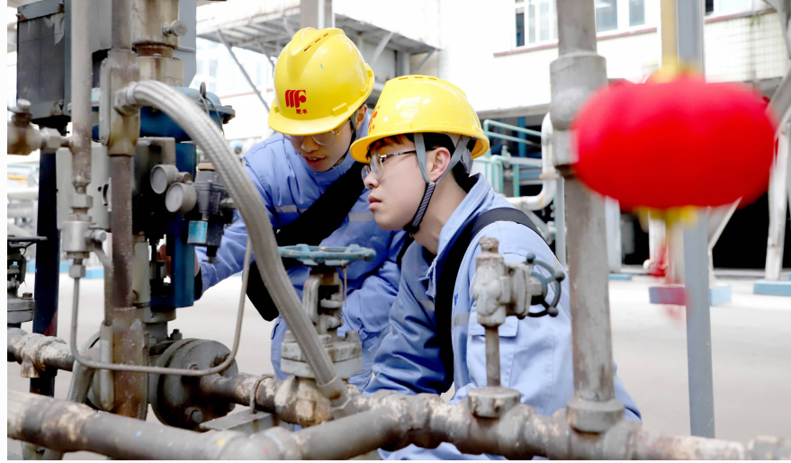
▲化肥分公司合成氨一车间巡检人员检查装置调节阀
