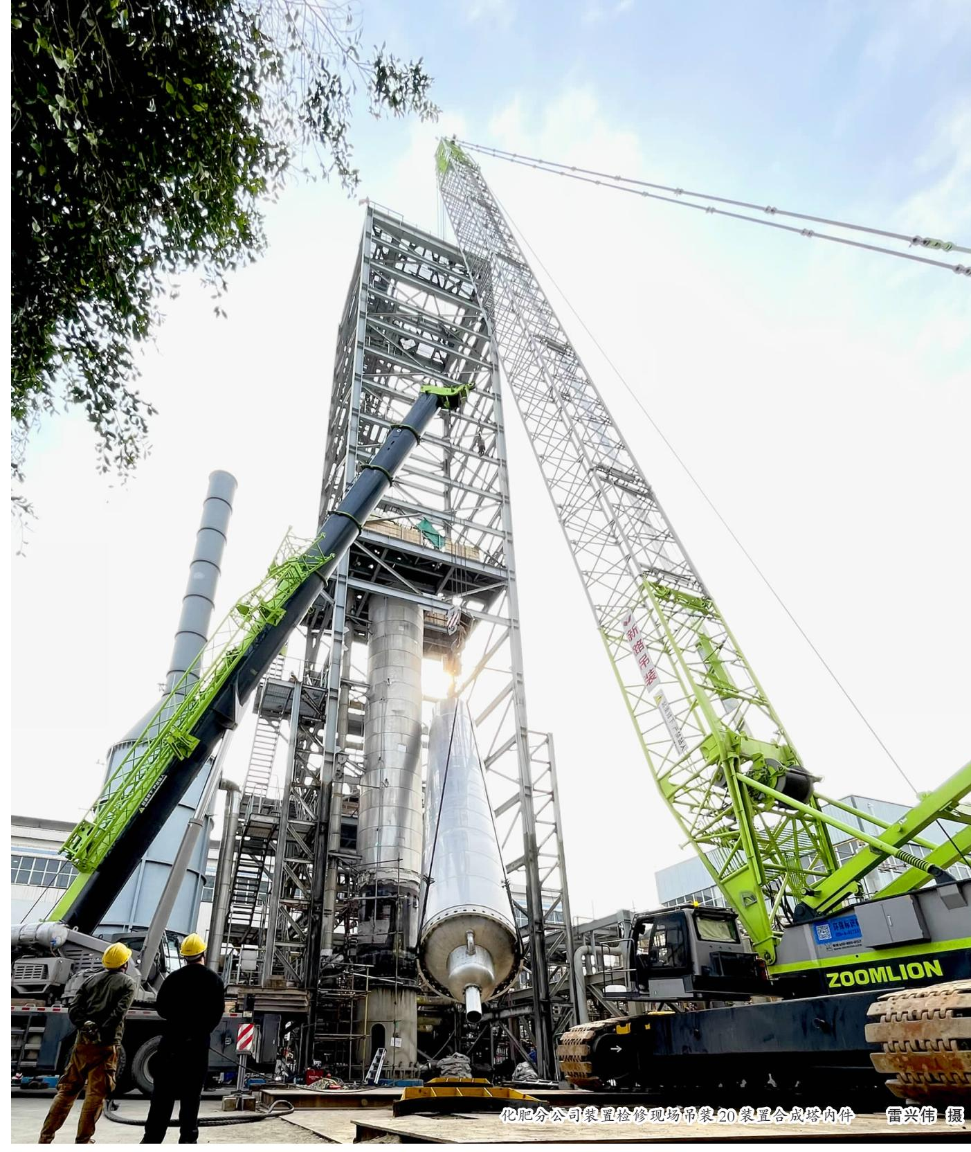
化肥分公司装置检修现场吊装20装置合成塔内件 雷兴伟 摄
